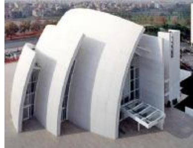
Bild 0-6 Links: Die Produktpalette EMACO® Nanocrete. Rechts: Die Jubiläumskirche in Rom, einer der meist zitierten Erfolge mit photokatalytischem Beton unter Beimischung von TiO 2 . Material: TX Active (TX Arca) von ItalCementi.
